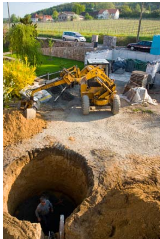
Die fertig ausgehobene Baugrube für den Klärbehälter.
