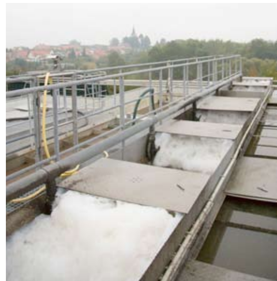
Blick über die Kläranlage der Gemeinde Biesenthal.
