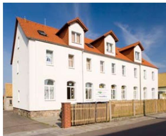
Gebäude mit Kindertageseinrichtung und 4 Wohnungen.
