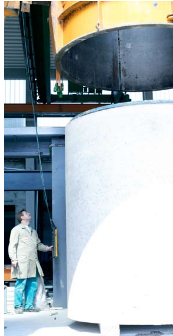
Die Außenhülle der künftigen Kleinkläranlage.
