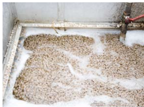
Die Aufwuchskörper (Kaldness) von WSB® clean.
