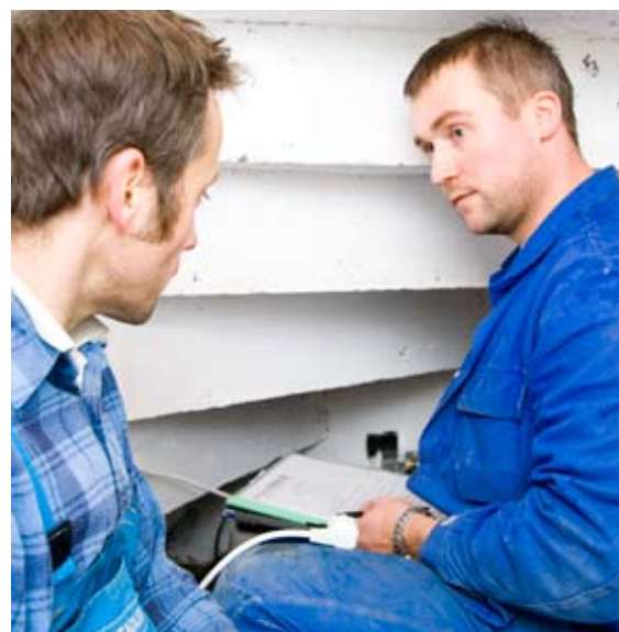
Montierung der Anlagensteuerung unter der Kellertreppe.
