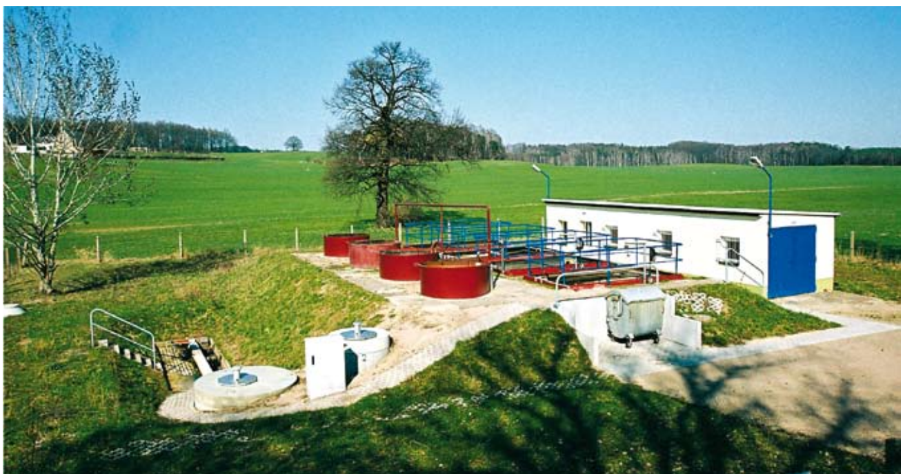
Kläranlage Bucha (Stand 2005; Foto: Holzberger)
