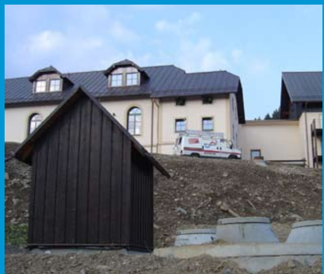
Verdichter und Steuerung wurden in einer Hütte installiert.
